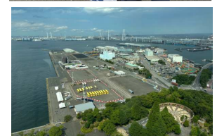
山下ふ頭全景
